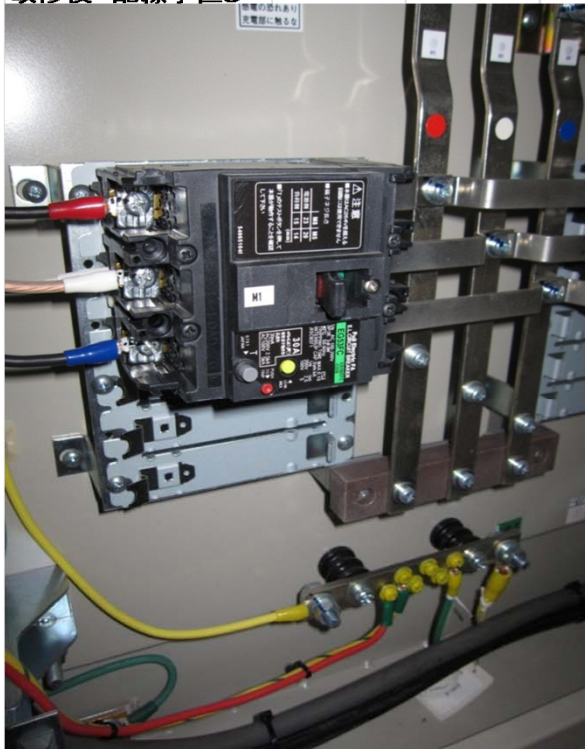
改修後 配線手直し
